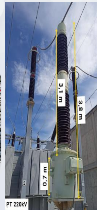
Transformadores de potencial 220kV
